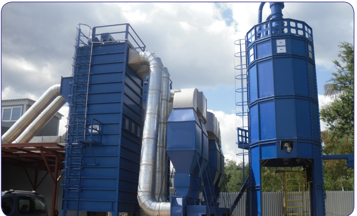
Система аспирации L= 100 000 м 3 /час. Рукавные фильтры с импульсной продувкой ФРИ-50СБ - 2 шт. Силос V= 5 0 м 3 с двойной выгрузкой: в котельную и в автомобиль. Фабрика PROFIL DOORS, г. Москва
