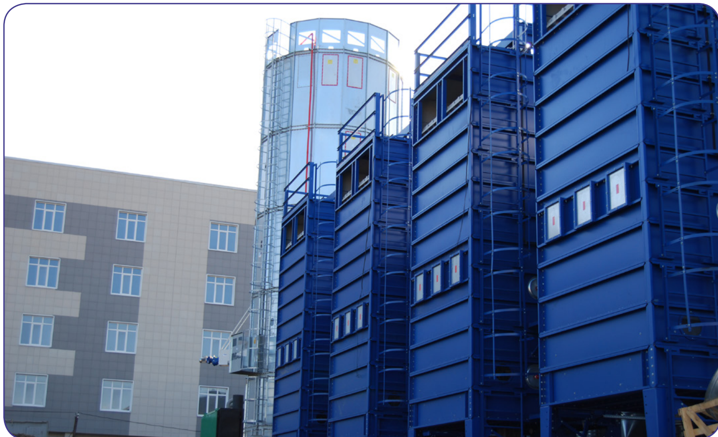
Система аспирации L = 200 м 3 /час. Рукавные фильтры с импульсной продувкой ФРИ-50СБ - 4 шт. Компания Кухонный Двор, г.Люберцы
