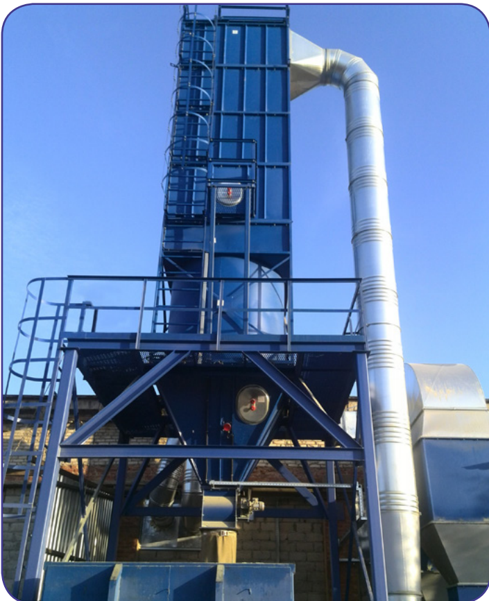
Система аспирации L= 32 000 м 3 /час. Рукавный фильтр с вибровстряхиванием ФР-32. Завод Невский ламинат, Ленинградская обл.
