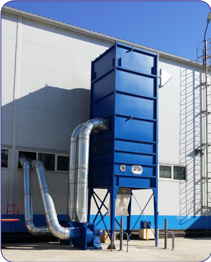
Комплект системы аспирации КСА-20 с мини-силосом. Компания ДИКОМ, г. Подольск
