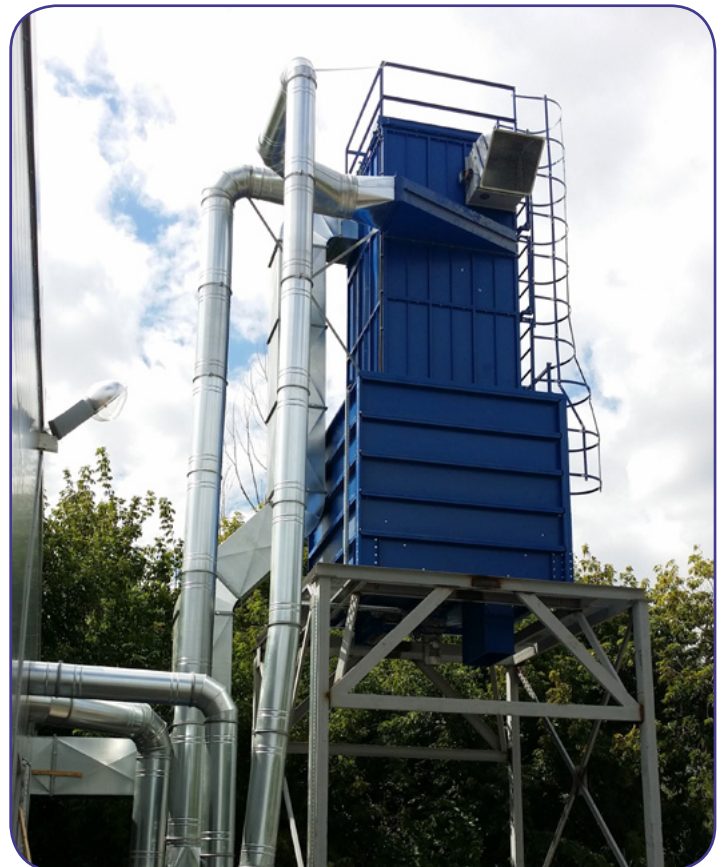
Система аспирации L= 16 000 м 3 /час. Рукавный фильтр с импульсной продувкой ФРИ-16 на мини-силосе 16 м 3 . Компания "Самарская Усадьба", Самарская обл.
