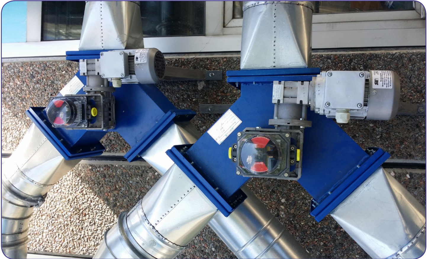
Дроссель-клапаны с пневмоприводом. Мебельная фабрика КожПромМебель, г. Рязань
