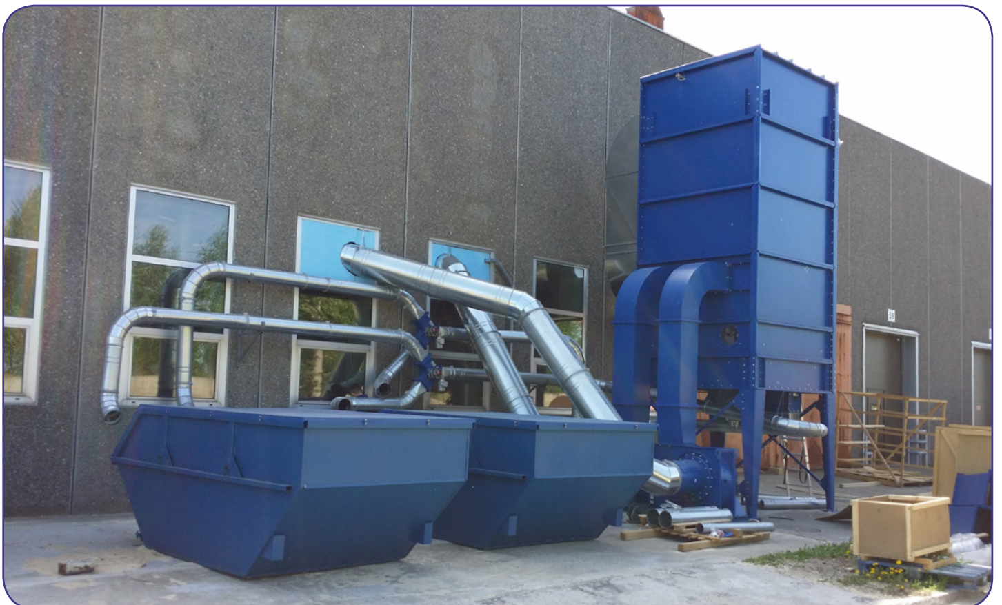
Комплект системы аспирации КСА-24 с мини-силосом и выгрузкой в герметичный контейнер. Мебельная фабрика КожПромМебель, г. Рязань
