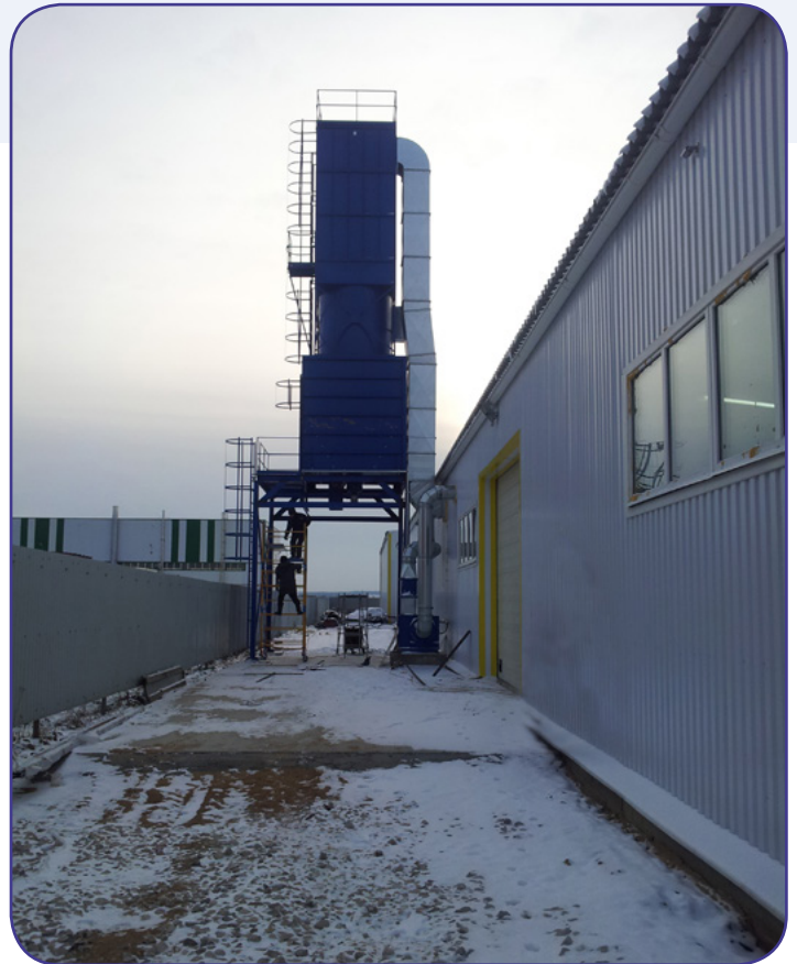
Система аспирации L= 20 000 м 3 /час. Рукавный фильтр с вибровстряхиванием ФР-20 на силосе V= 20 м 3 . Компания ЖуковЛес, Калужская обл., г. Жуков
