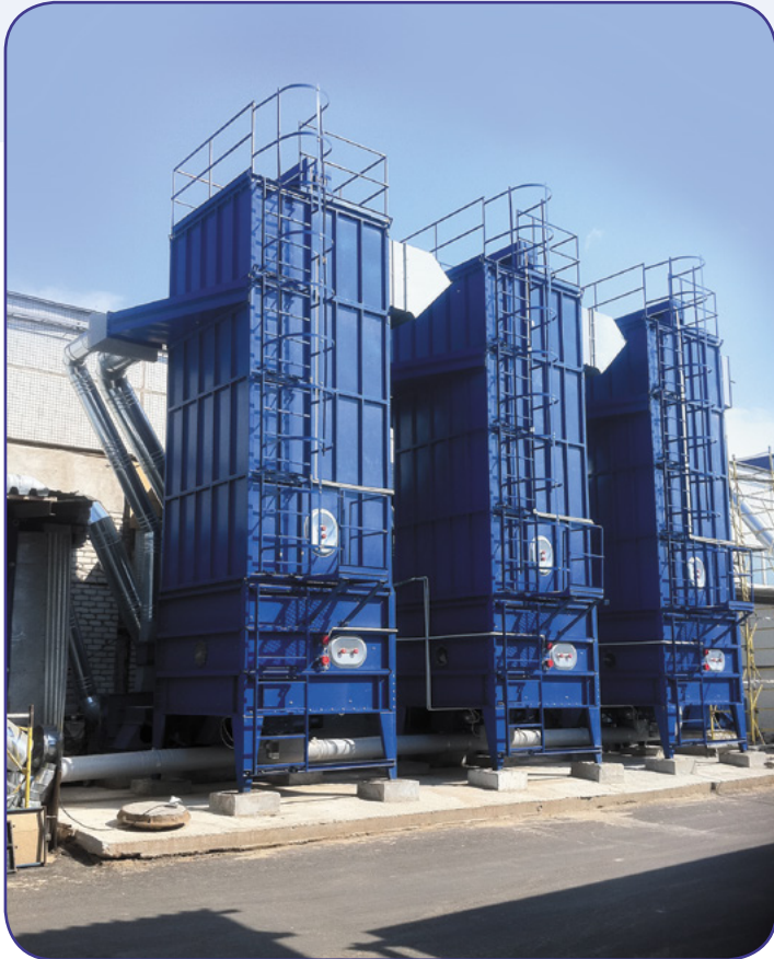
Система аспирации L= 100 000 м 3 /час. Рукавные фильтры с импульсной продувкой ФРИ-32 - 3 шт. Компания BELWOODOORS г. Минск
