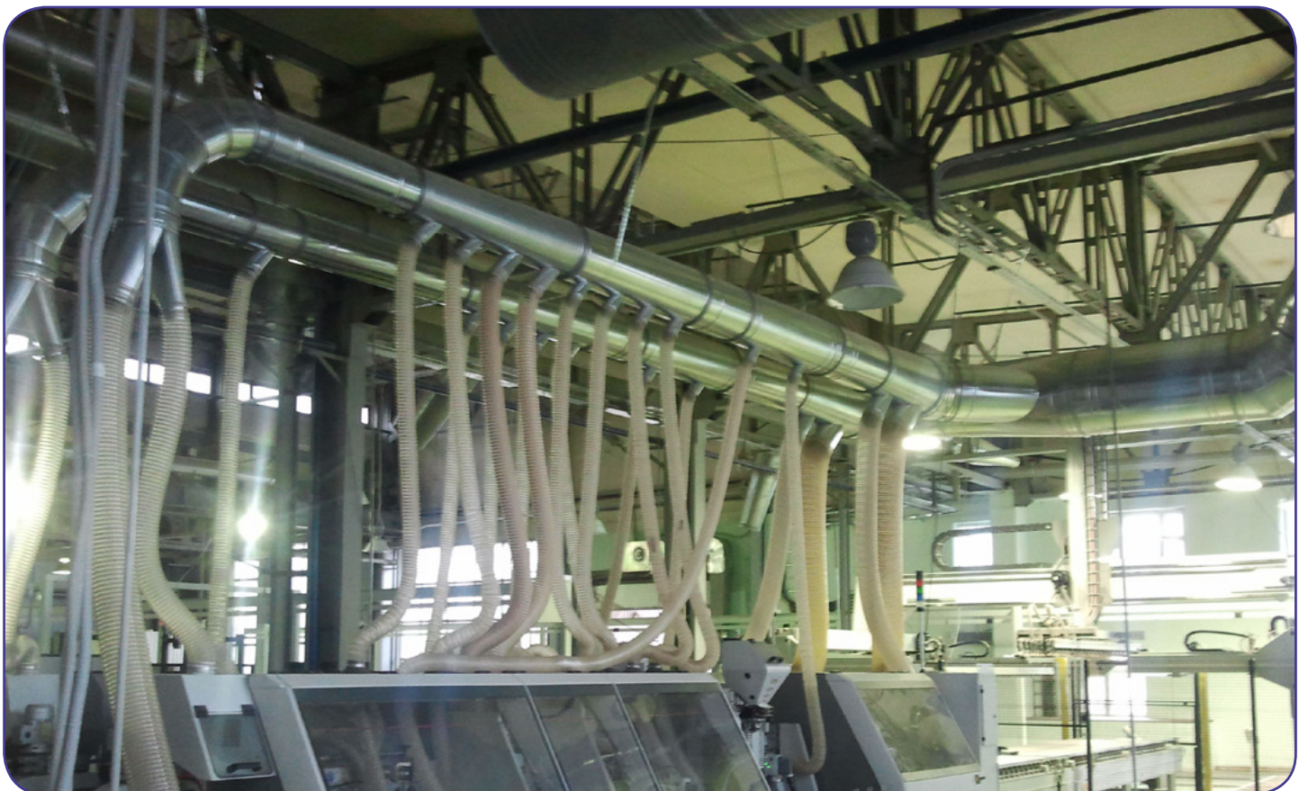
Система аспирации L = 120 000 м 3 /час. Система воздуховодов. Компания Феликс, г. Москва
