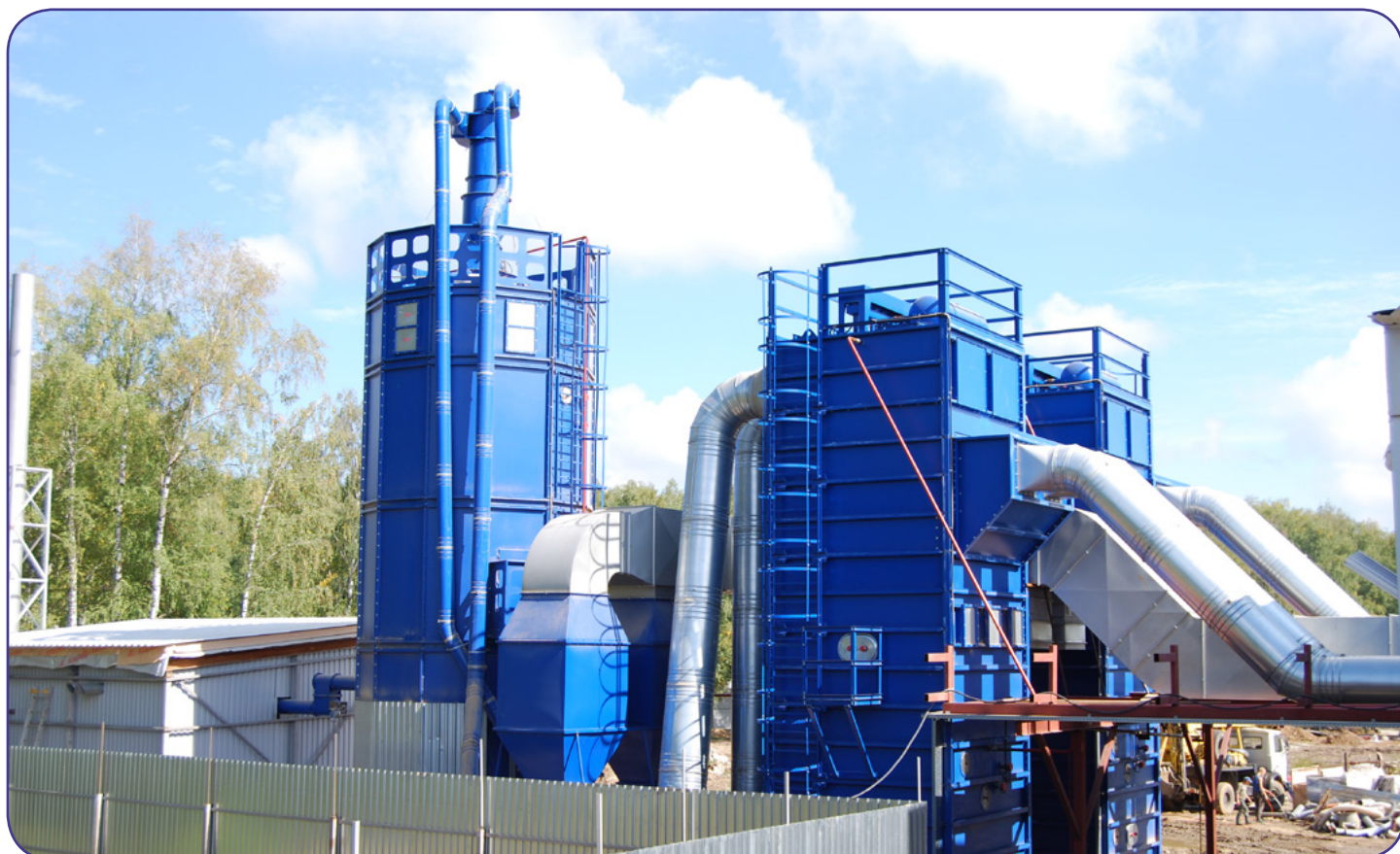
Система аспирации L= 100 000 м 3 /час. Рукавные фильтры с импульсной продувкой ФРИ-50СБ - 2 шт. Выгрузка в силос V= 5 0 м 3 . Фабрика PROFIL DOORS, г. Москва
